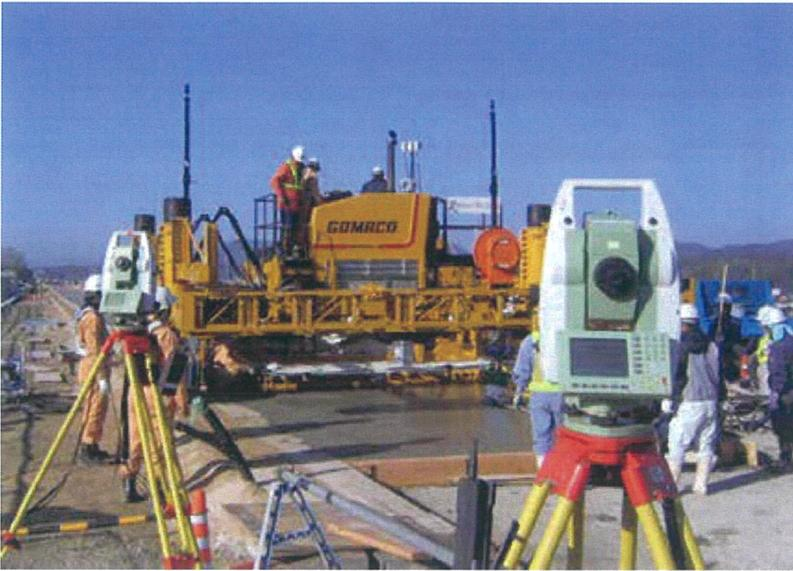
写真7 3DMCによる成型仕上げ状況の例
