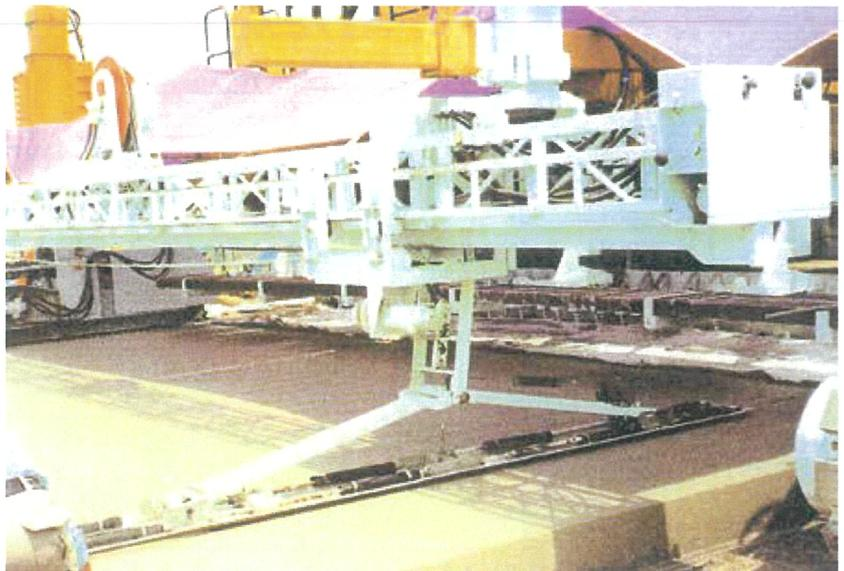
写真8 スリップフォームペーバによる成型仕上げ状況の例
