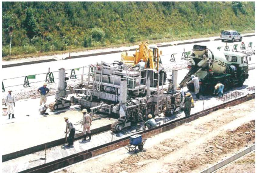
写真11 舗装用中型機による舗設状況の例（無筋）
