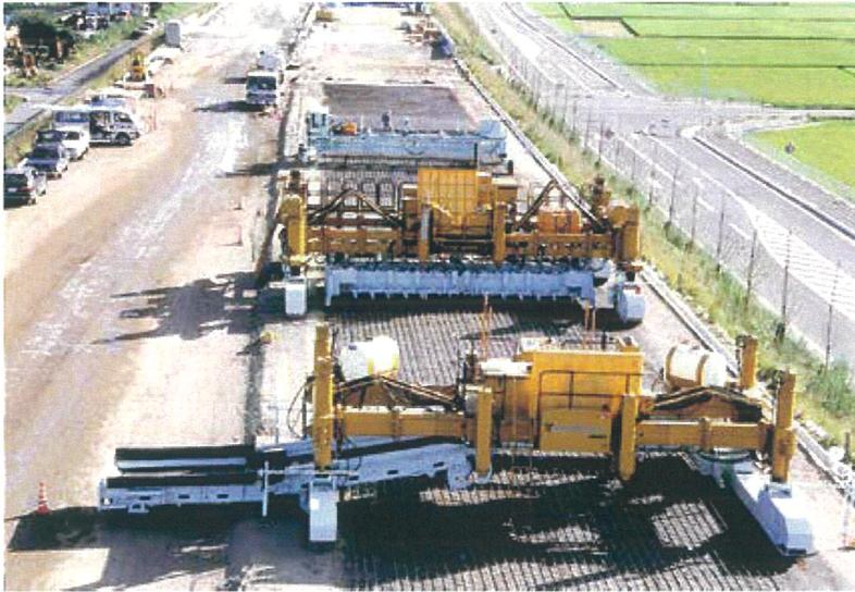
写真1 舗装用大型機による機械編成の例
