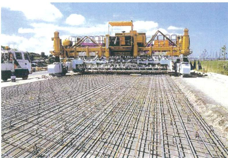
写真3 連続鉄筋の設置状況の例
