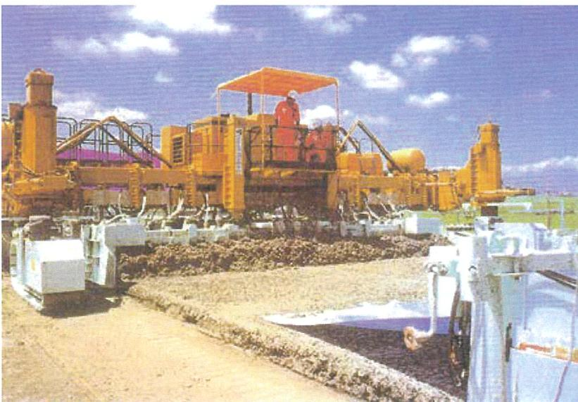
写真6 スリップフォームペーバによるコンクリートの締固め状況の例
