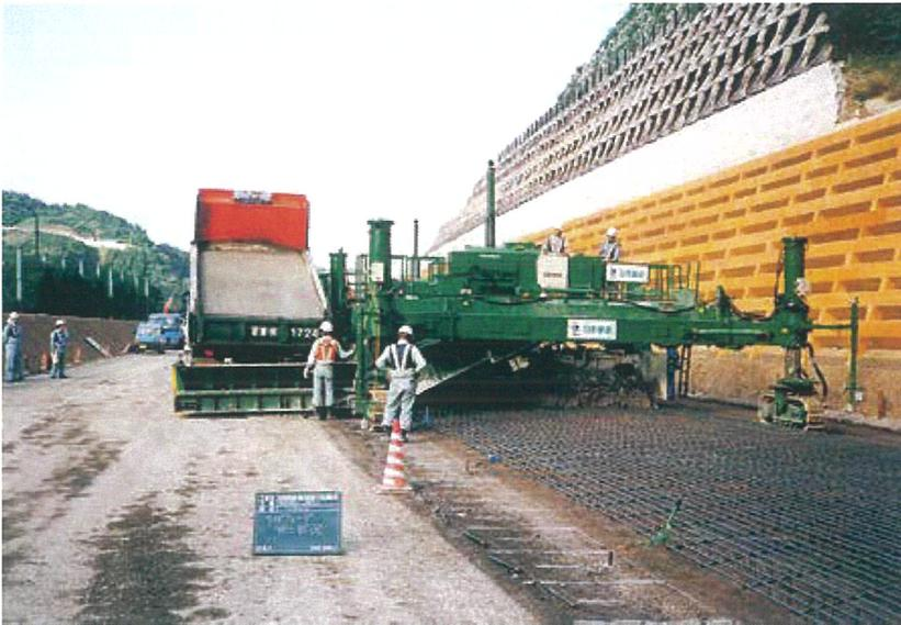
写真4 スリップフォームスプレッタによるコンクリートの横取り状況の例
