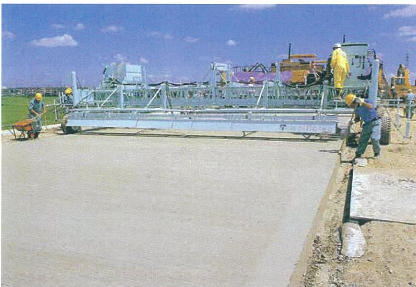
写真9 キュアリングマシンによる粗面仕上げ状況の例
