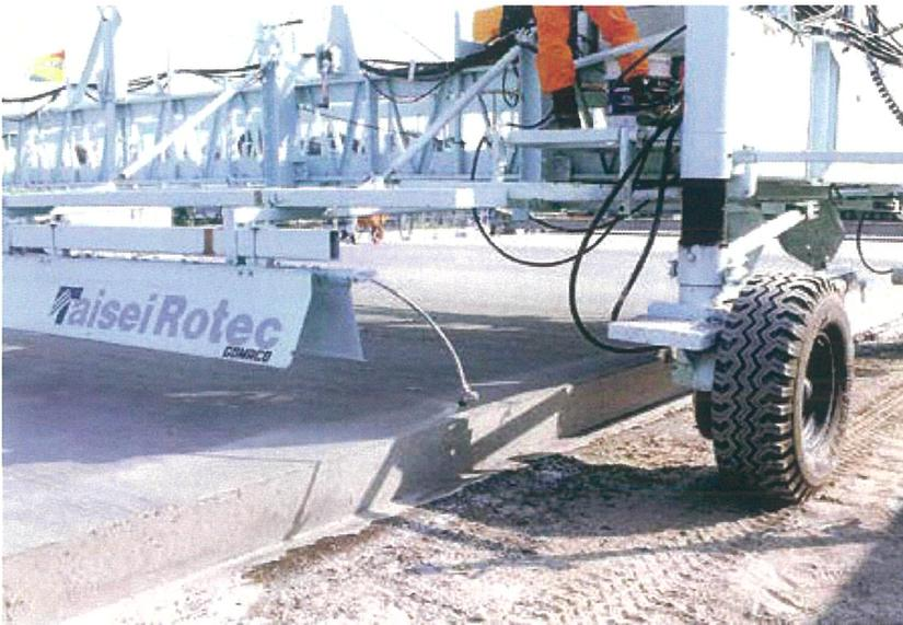
写真10 キュアリングマシンによる養生剤散布状況の例
