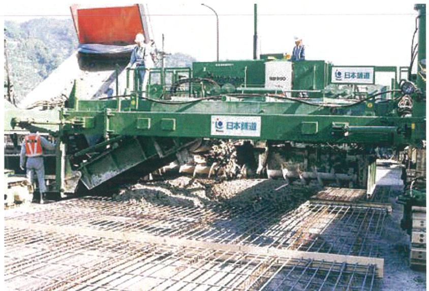
写真5 スリップフォームスプレッタによるコンクリートの敷きならし状況の例
