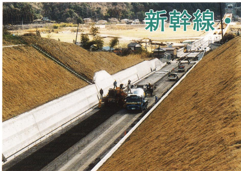
スリップフォーム工法による新幹線・明り部コンクリート路盤工の直線部施工状況
