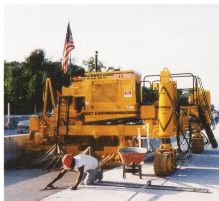
▲中分防護柵にすりつけてゼロ・クリアランス舗装施工
