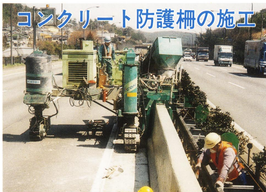
スリップフォーム工法によるコンクリート防護柵の施工状況
