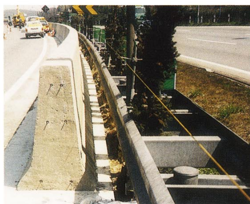
ガードレールと平行に完成したコンクリート防護柵
