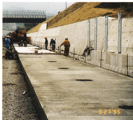
スリップフォーム工法による新幹線・明り部コンクリート路盤工の直線部施工状況
