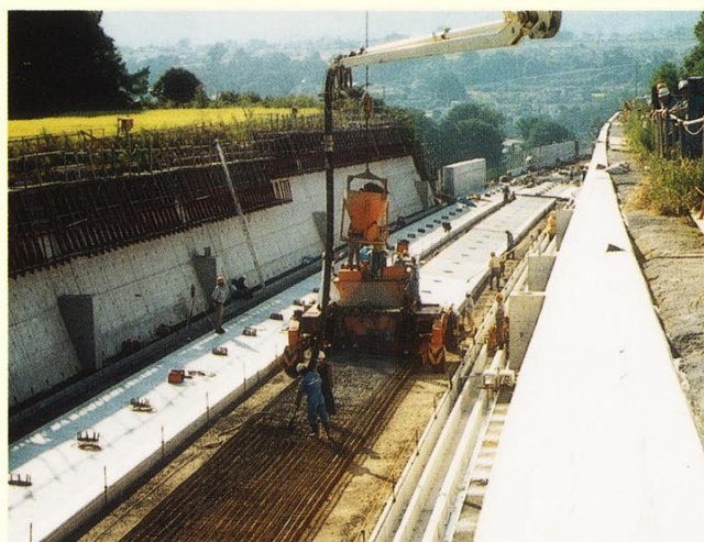
下り線軌道部打設状況
