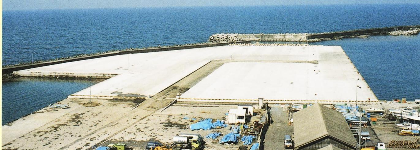
型枠を使用したスリップフォームペーバ（MF600）によるコンクリート舗装を紹介する。
