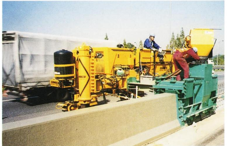
現在、わが国の高速道路において、中央分離帯および路肩の防護柵が剛性防護柵に急激な勢いで替わりつつある。その中でもスリップフォーム工法によるコンクリート防護柵が殆どである。というのは、SF工法は他の工法と比較しても施工速度の早さ、事前の準備期間の少なさ、施工費用の安さという有利な点が多いからであろう。
