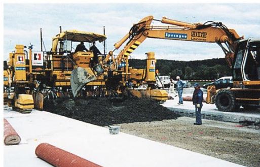
写真-3 施工状況（チューリッヒ空港）
