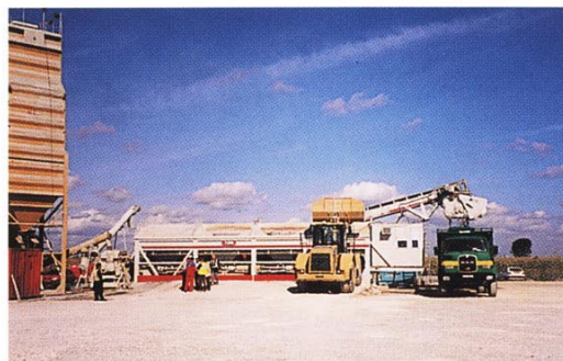
写真-2 連続ミキサによるコンクリート製造（オルリー空港）
