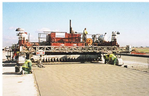
写真-1 施工状況（オルリー空港）
