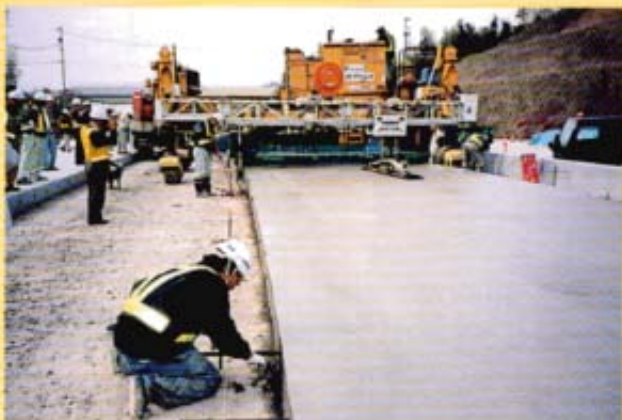
施工現場の状況
