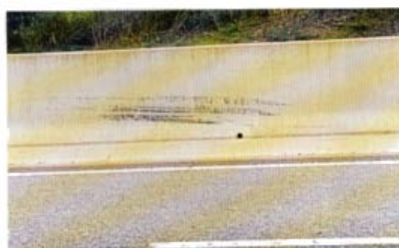
コンクリート防護柵
