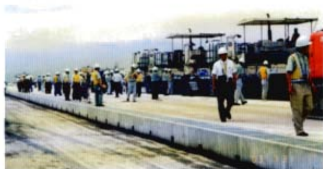
AP3施工状況
