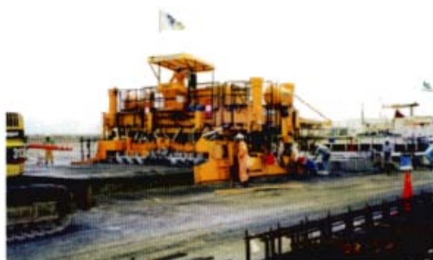
AP2施工状況
