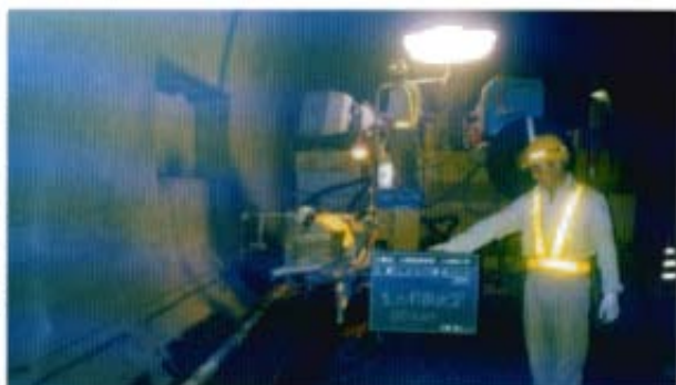
SF φ350 打設
