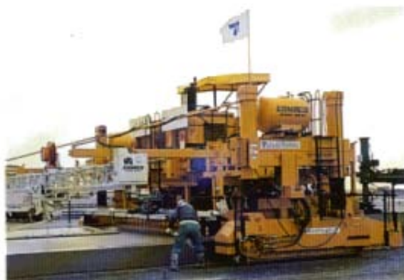
中部国際空港エプロン舗装工事
