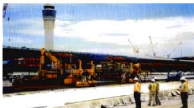
AP1施工状況
