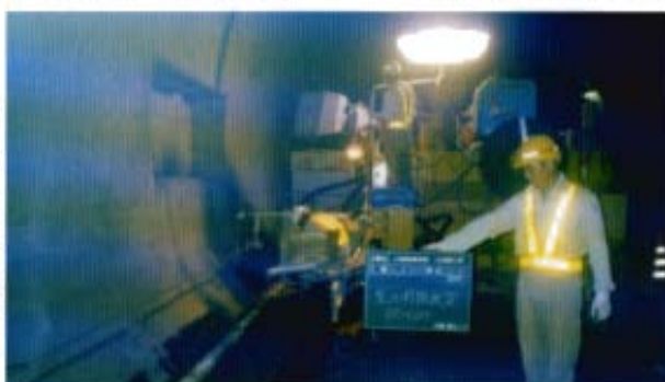
SF φ350 打設
