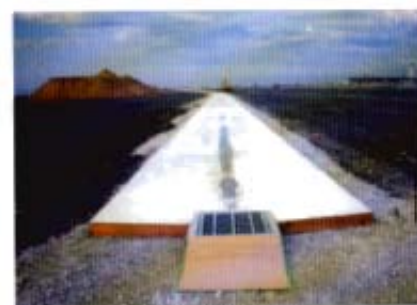
仕上がり状況
