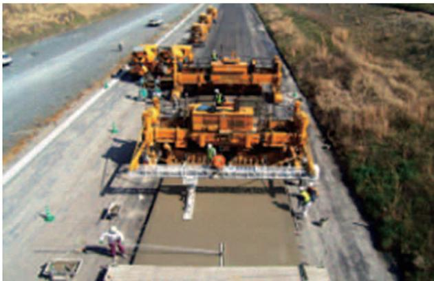
写真 2 打設状況（後打ち）
