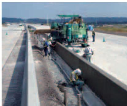
施工に際しては、コンクリート防護柵の安定化のため、基礎形状および防護柵背面に必要なコンクリートシール等の提案を行った。
