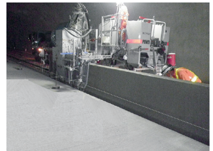
写真-3 中央分離帯コン クリート防護柵施 工 (防護柵施工： 有こやな川)
