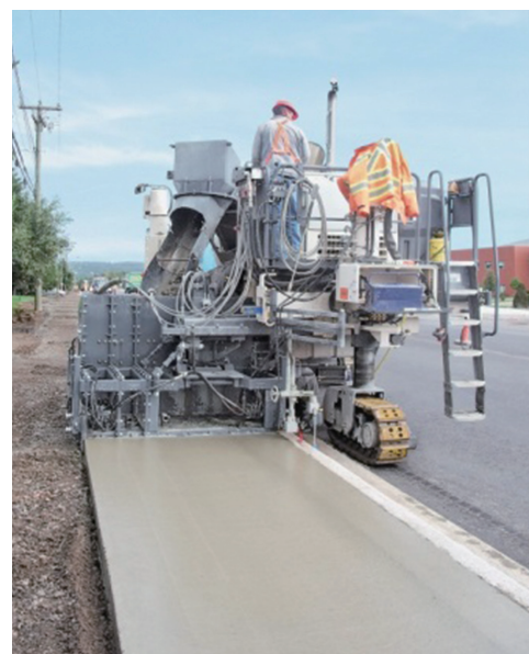
1.8m 幅舗装施工
