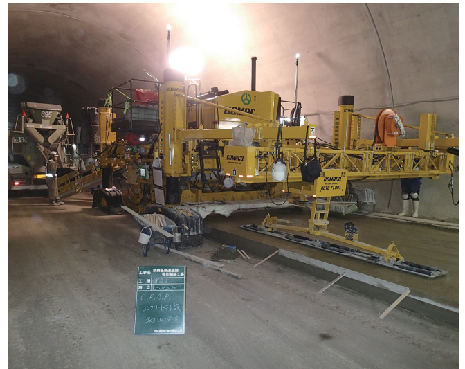
写真3 トンネル部の施工状況
