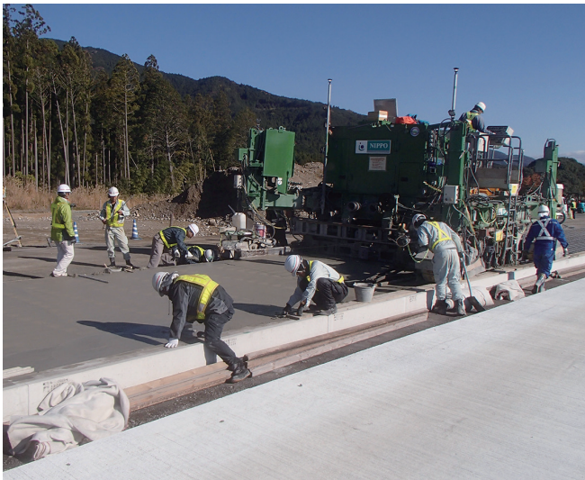
写真1 土工部の施工状況
