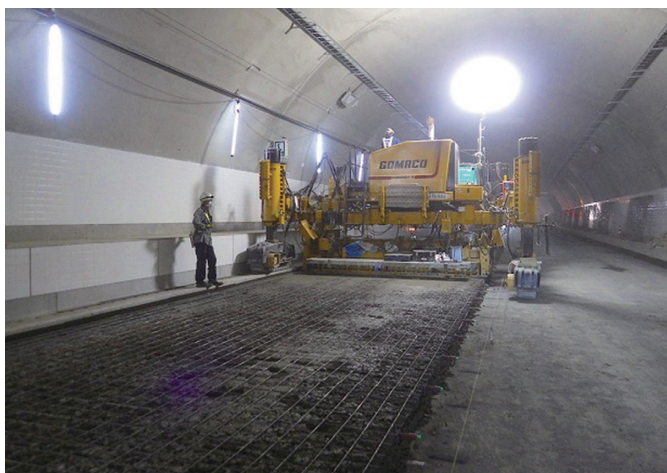
下層コンクリート敷ならし状況
