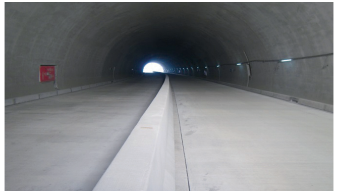
写真-1 舗装・防護柵完了
