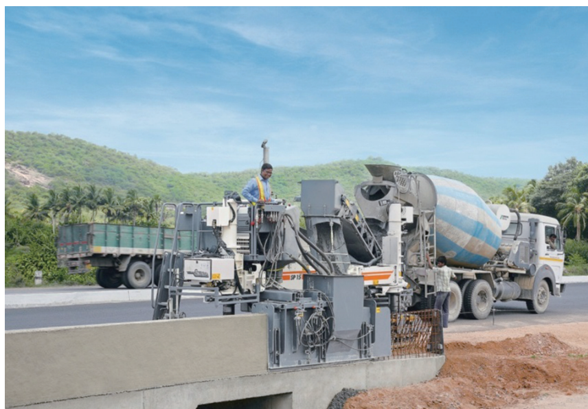
1.3m 高さ防護柵施工
