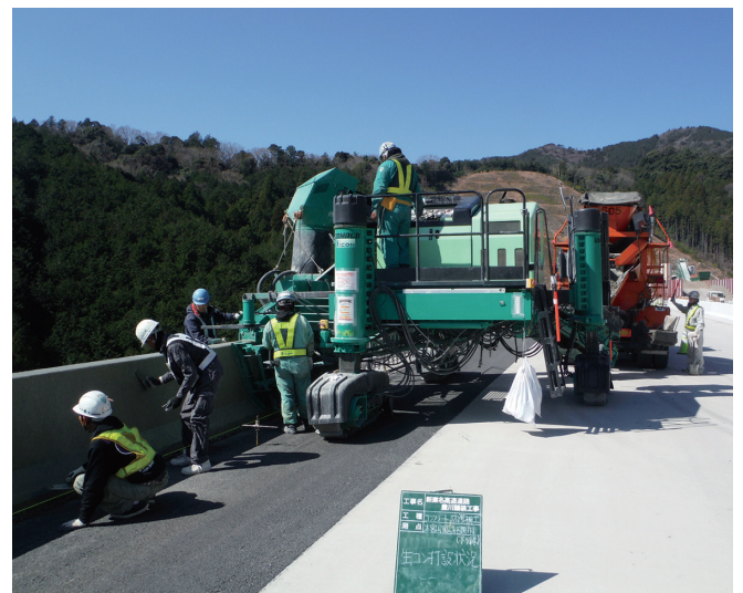
写真4 コンクリート防護柵の施工状況
