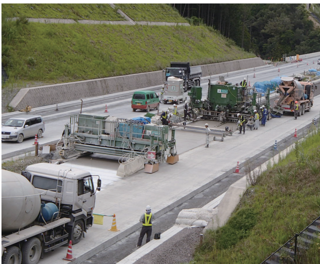
写真2 土工部の施工状況
