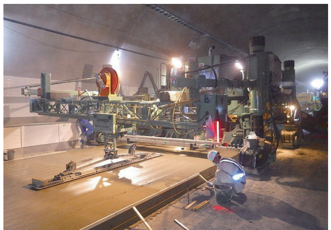
上層コンクリート敷ならし・成形状況
