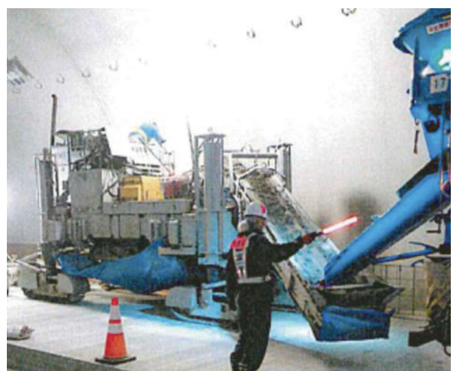
写真－２ R 側施工機パワーカーバー
