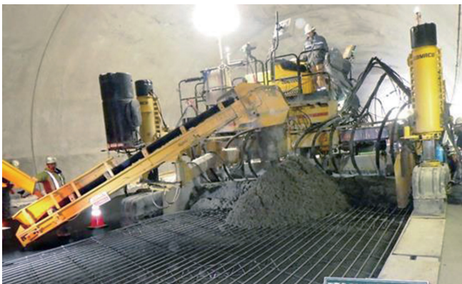
連続鉄筋コンクリート舗装
