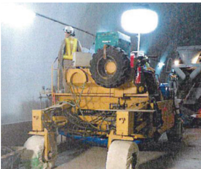
写真－１ L 側施工機ヒューロン
