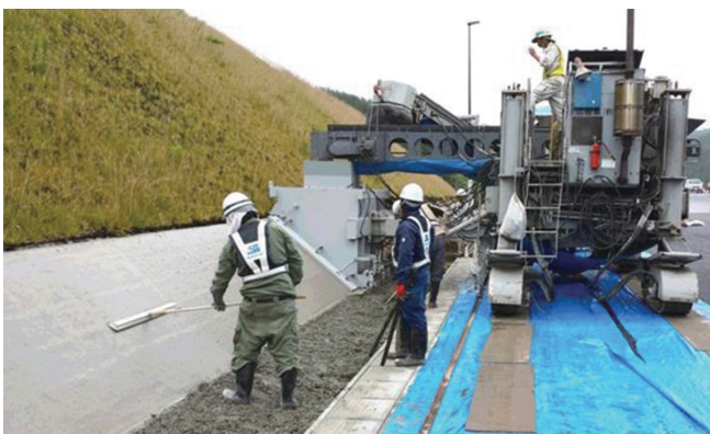
明かり部 防草工
