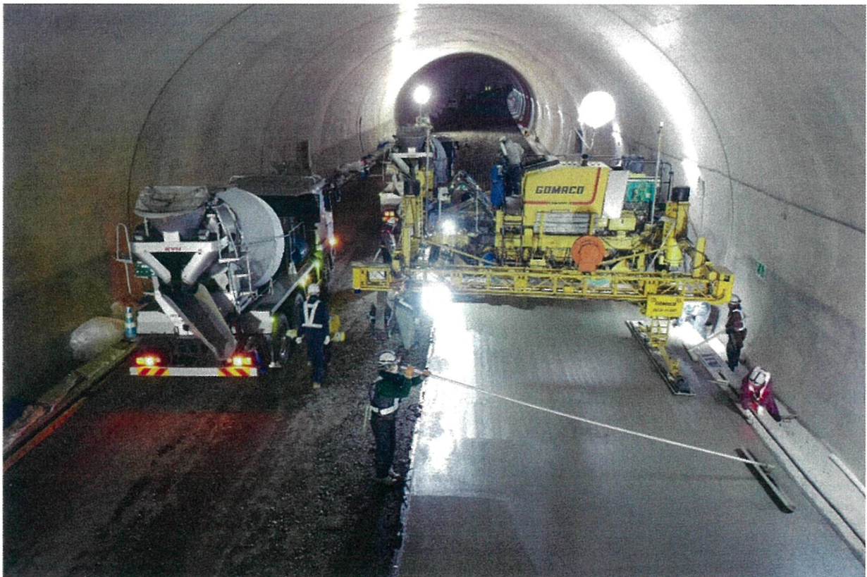
写真－1 スリップフォームペーバによるコンクリート舗装の施工状況
