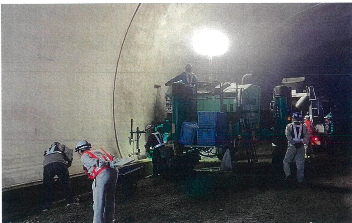
写真－２ スリップフォーム工法による円形側溝の施工
