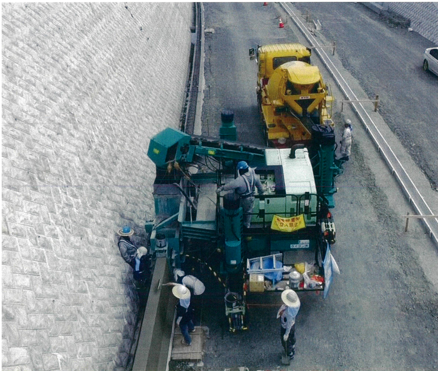
新東名高速道路 伊勢原北 IC ～ 秦野 IC 間舗装工事
