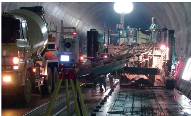
トータルステーションを用いた 3D システムによる鉄道路盤施工
