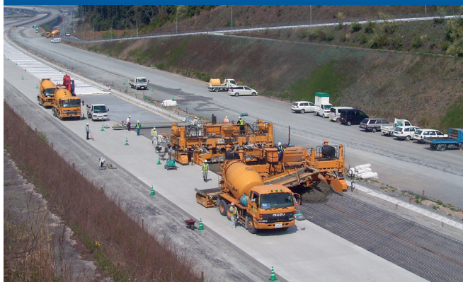
片側 3 車線道路 2 分割舗装を本格的初施工
