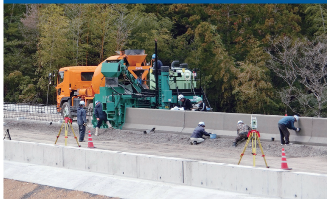
SF 工法による防護柵の 3D 施工
