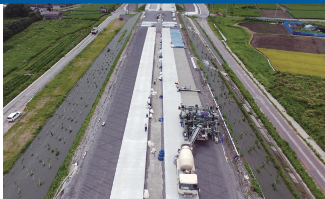
新名神高速道路 鈴鹿舗装工事
