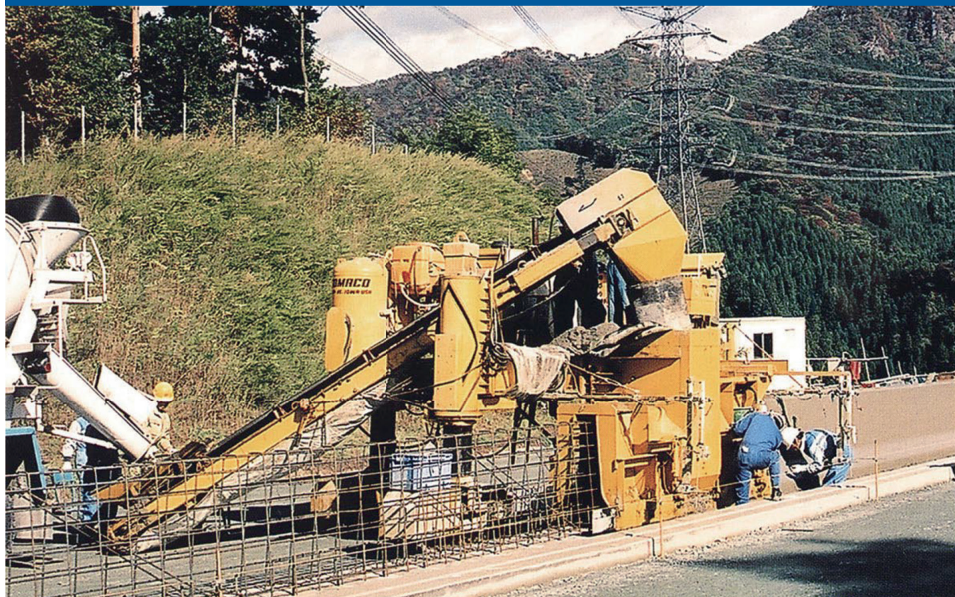
上信越道・碓氷での防護柵初施工
