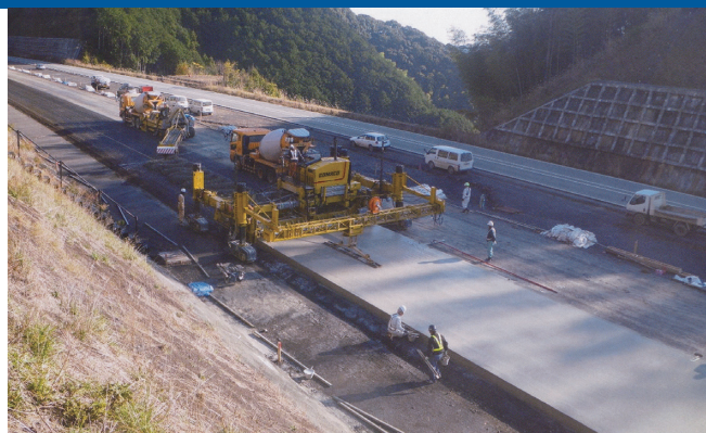
新東名高速道路の連続鉄筋コンクリート舗装
