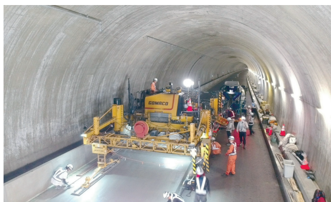
新東名での 3D による連続鉄筋コンクリート舗装施工
