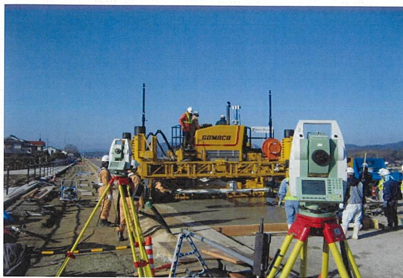
写真10 3DMCによる成型仕上げ状況の例
