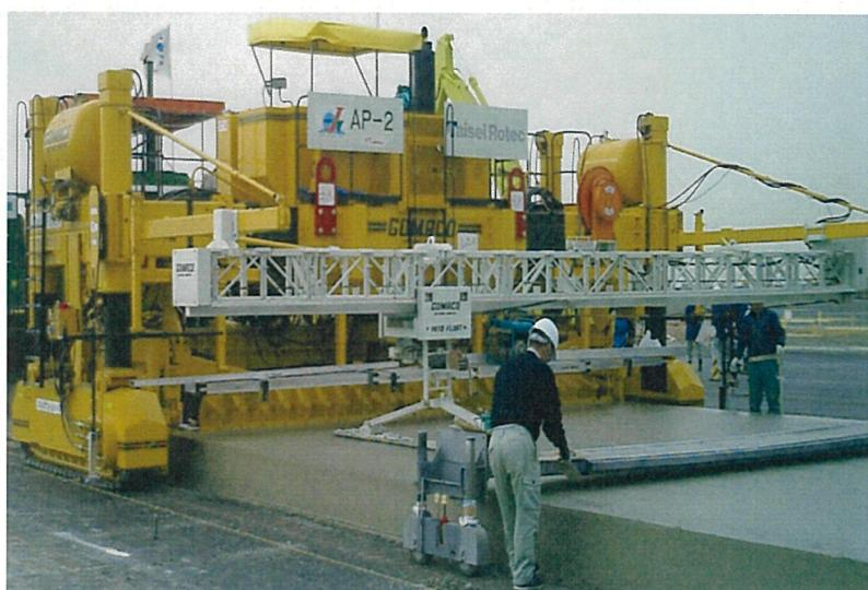
写真6 スリップフォームペーバによるコンクリートの締固め状況の例
