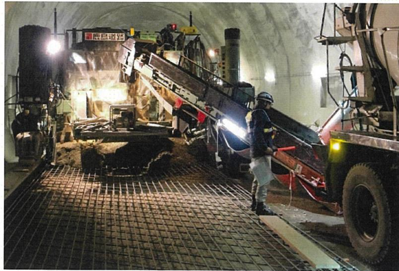
写真12 補装用中型機によるトンネル内補設状況の例（ベルコン付）
