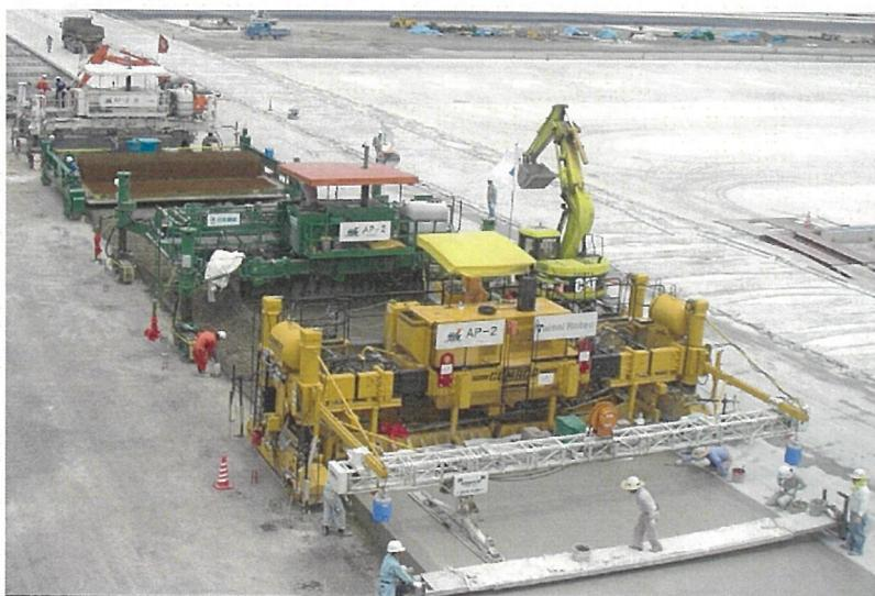
写真1 舗装用大型機による機械編成の例
