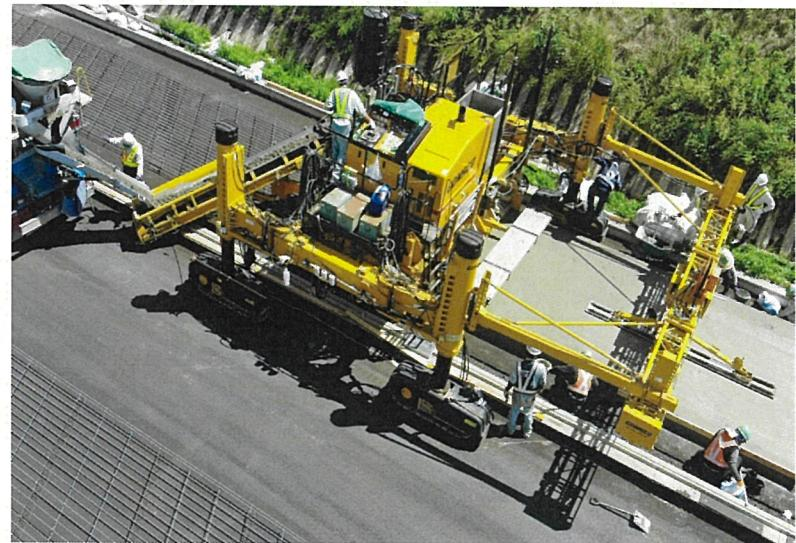
写真11 補装用中型機による補設状況の例（連続鉄筋）
