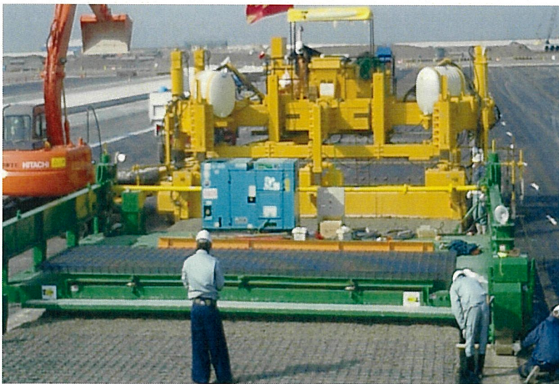
写真4 メッシュカートによる溶接金網設置状況の例
