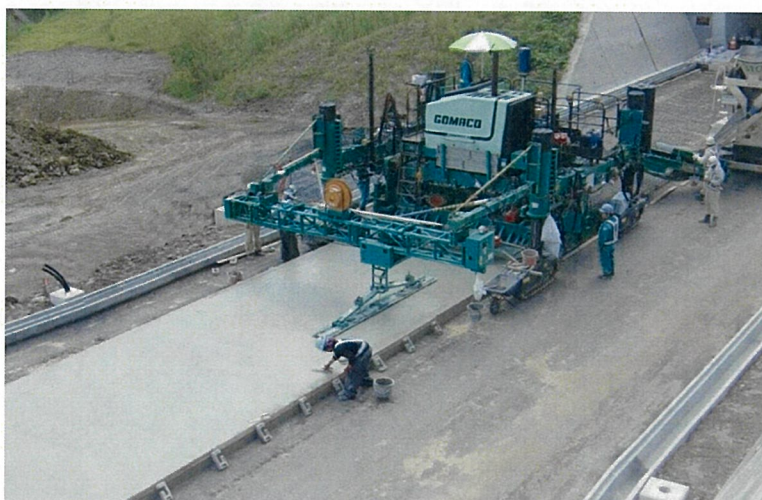
マシンコントロールで施工中
