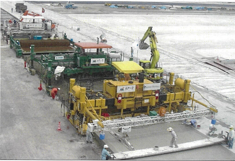
写真1 舗装用大型機による機械編成の例
