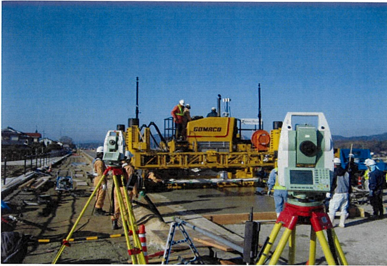
写真10 3DMCによる成型仕上げ状況の例
