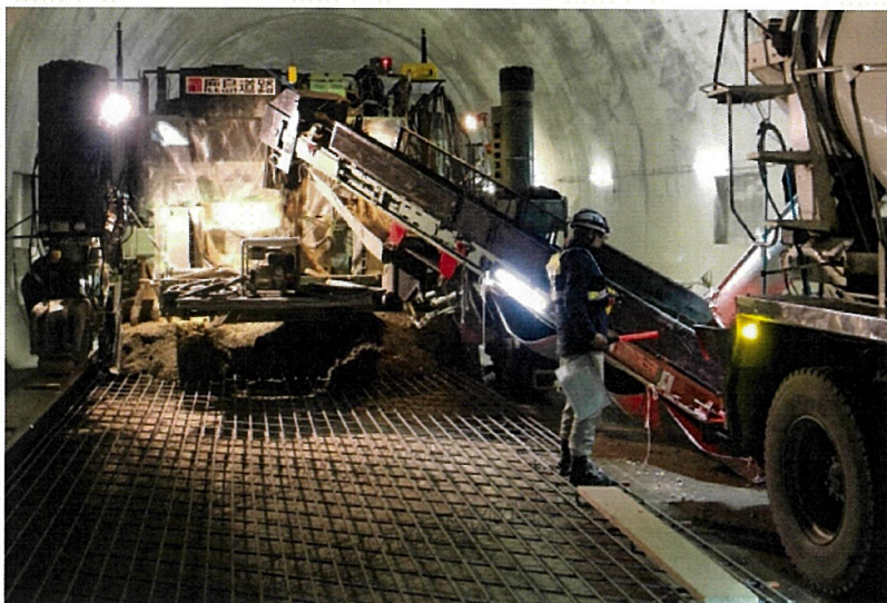
写真12 舗装用中型機によるトンネル内舗設状況の例（ベルコン付）
