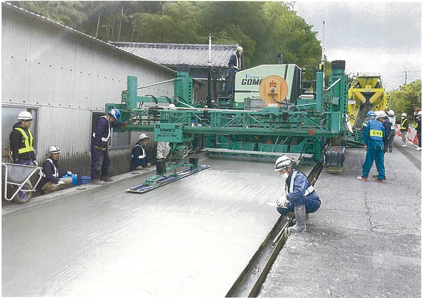
写真 1 善通寺管内舗装 施工状況
