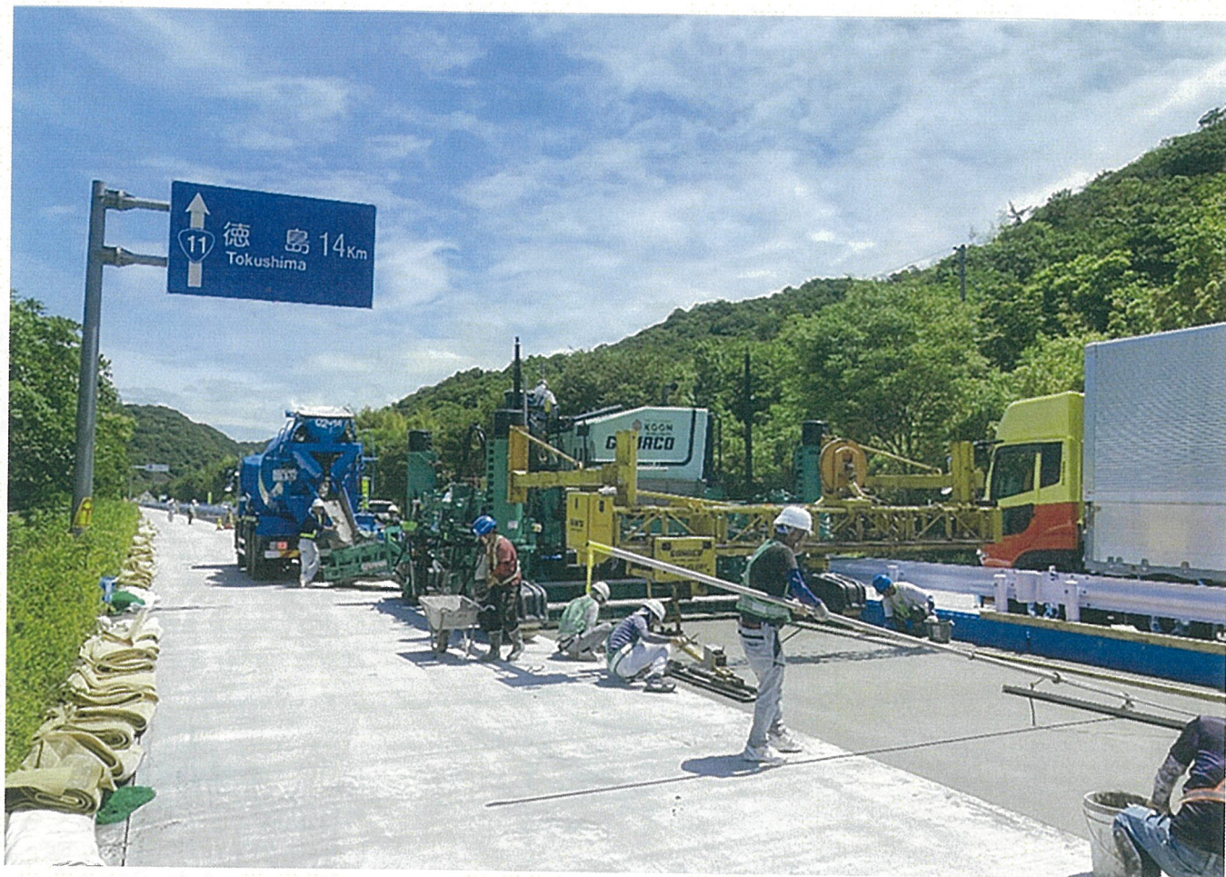
写真 2 鳴門地区舗装 施工状況
