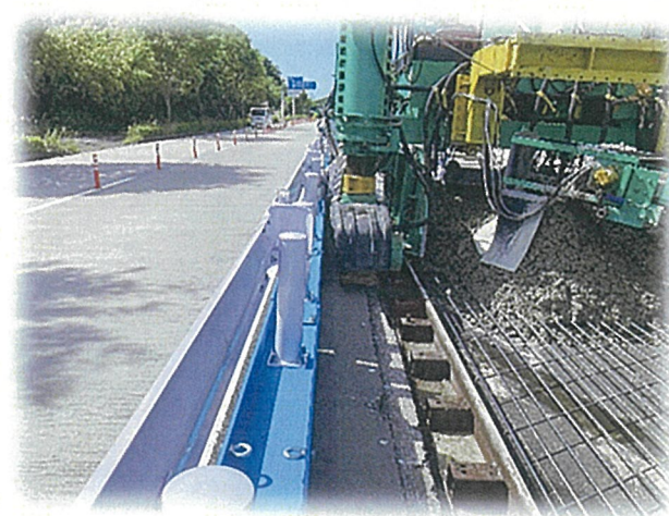
写真 4 鳴門地区舗装 走路
