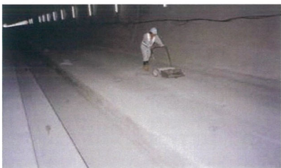
①コンクリート面の清掃
