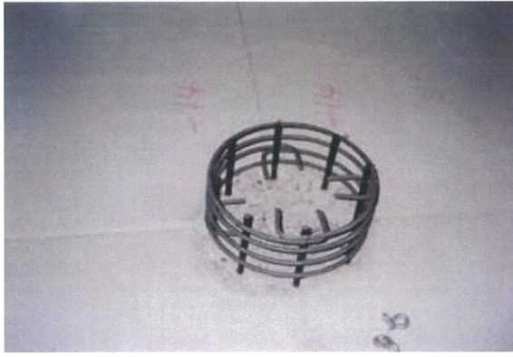
⑮突起コンクリート上部鉄筋設置
