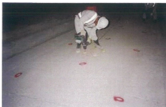
②アンカー筋のマーキング削孔
