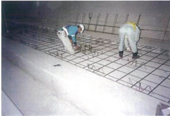
⑥鉄筋(メッシュ筋)の組立設置
