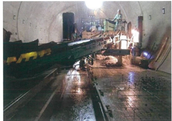
⑪コンクリート打設
