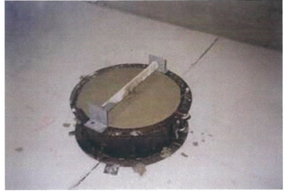
⑯突起コンクリート打設
