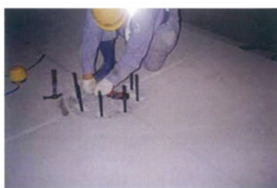
⑰突起上部鉄筋組立
