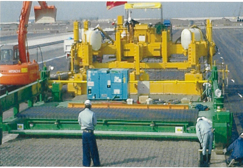
写真4 メッシュカートによる溶接金網設置状況の例
