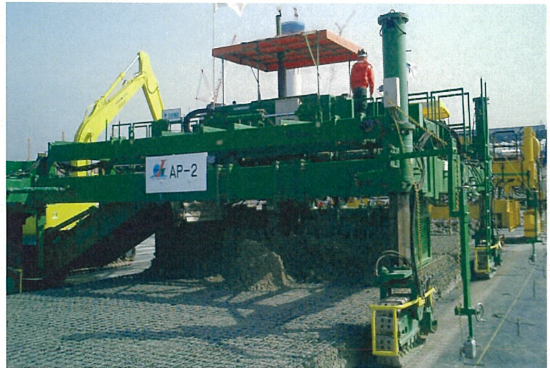
写真5 スリップフォームスプレッダによる上層コンクリート敷均し状況の例
