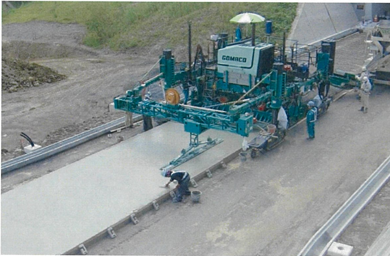
マシンコントロールで施工中
