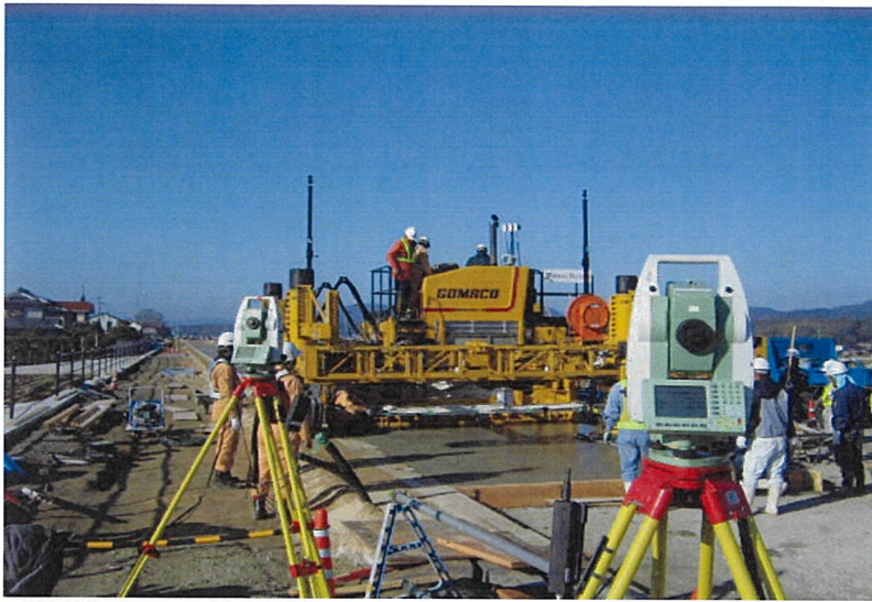
写真10 3DMCによる成型仕上げ状況の例
