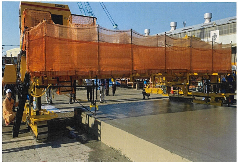
写真8 キュアリングマシンによる粗面仕上げ状況の例
