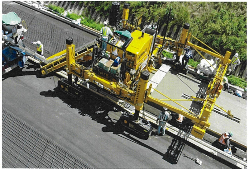
写真11 舗装用中型機による舗設状況の例（連続鉄筋）
