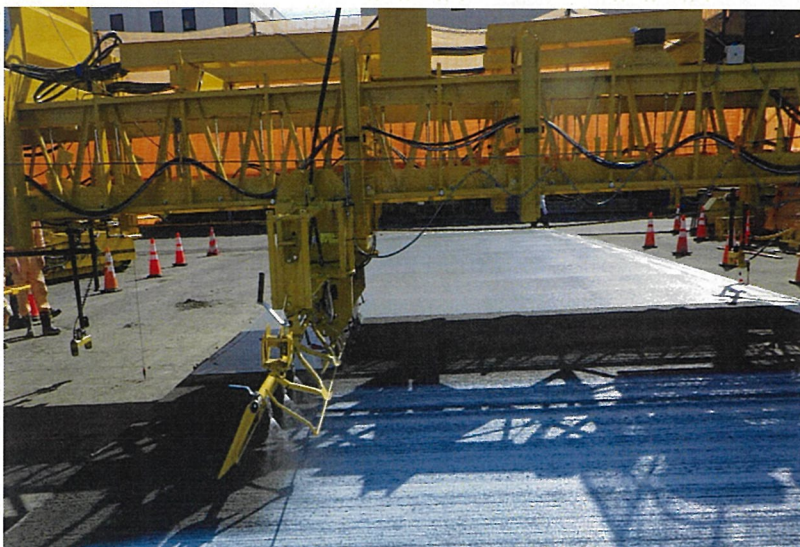
写真9 キュアリングマシンによる養生剤散布状況の例
