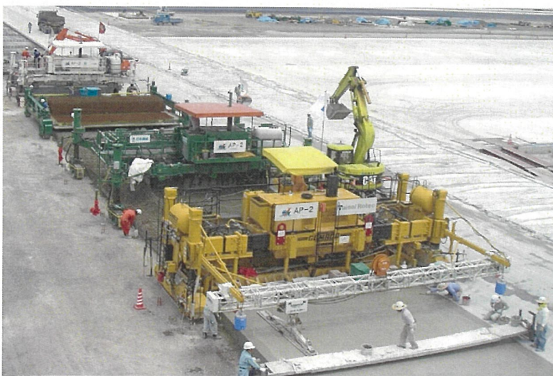
写真1 舗装用大型機による機械編成の例
