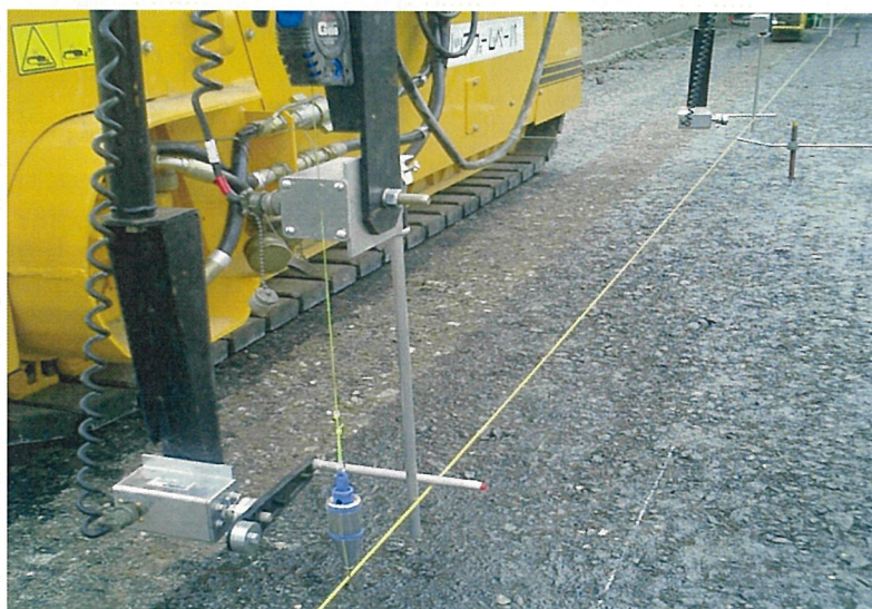
写真2 センサライン設置状況の例
