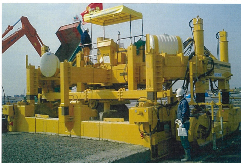
写真3 スリップフォームプレッタによる下層コンクリート敷均し状況の例
