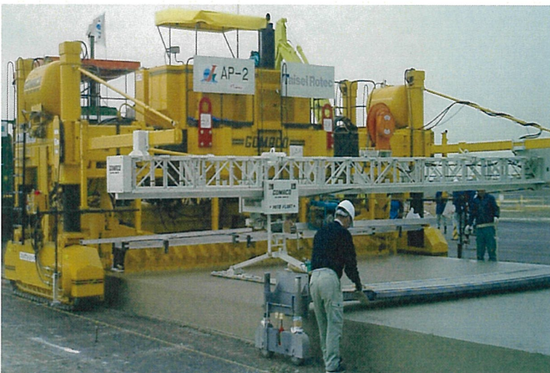
写真6 スリップフォームペーパーによるコンクリートの締固め状況の例
