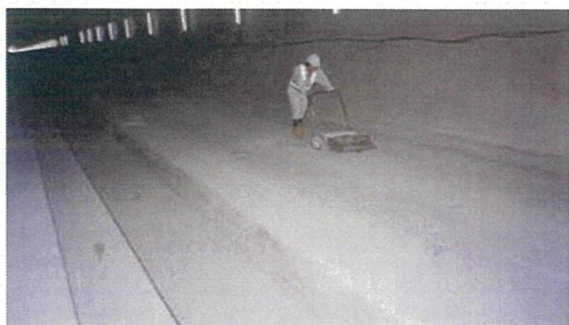
①コンクリート面の清掃
