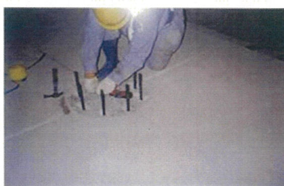
⑰突起上部鉄筋組立
