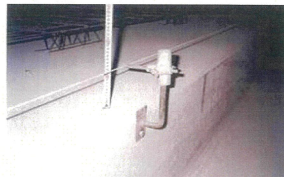
⑨センサラインの設置工(通路側)
