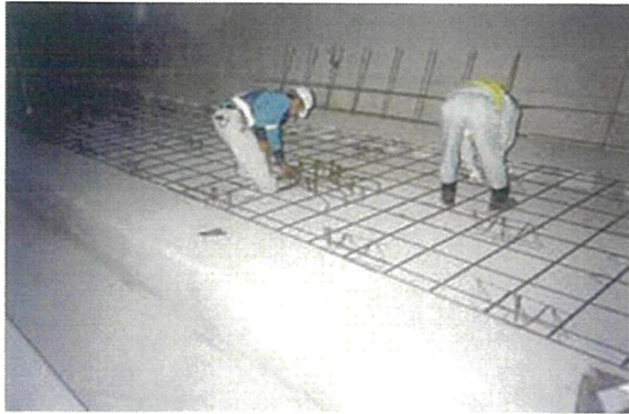
⑥鉄筋(メッシュ筋)の組立設置
