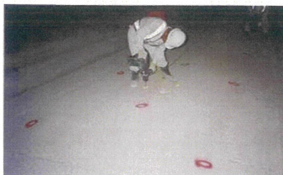
②アンカー筋のマーキング削孔
