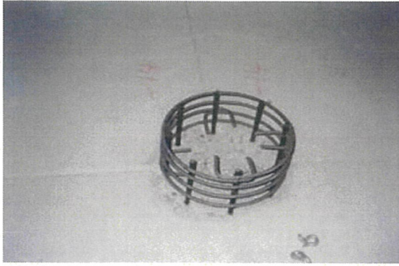
⑱突起コンクリート上部鉄筋設置
