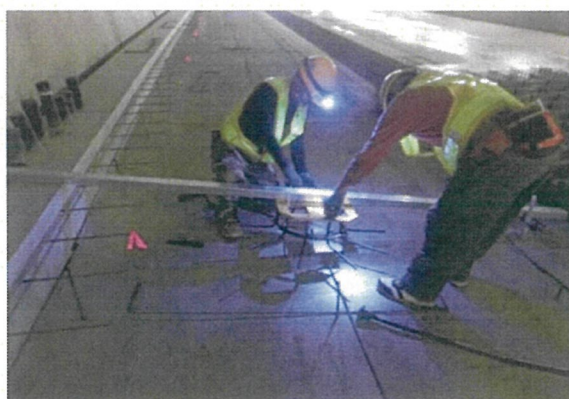
④突起コンクリート下部鉄筋設置
