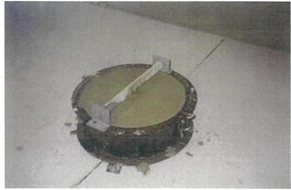
⑲突起コンクリート打設
