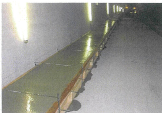
③軌道外部施工
