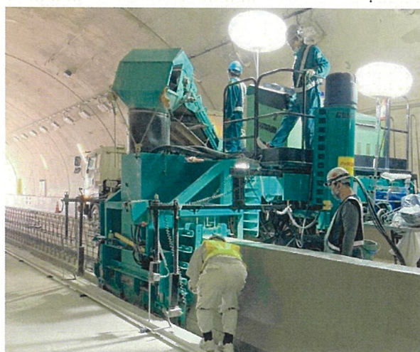
コンクリート防護柵
