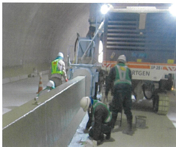
コンクリート防護柵
