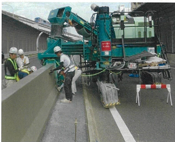
コンクリート防護柵
